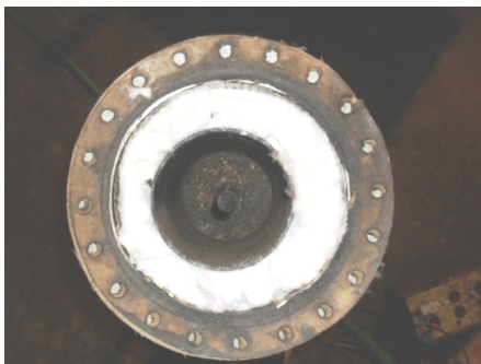
Figura 5: Isolamento térmico com lã de vidro
