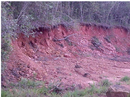
Figura 3: Caixa de empréstimo de terra, área totalmente desprotegida de Vegetação, lixiviação de nutrientes; Fonte: Borszowskei, P., R., (2008).
