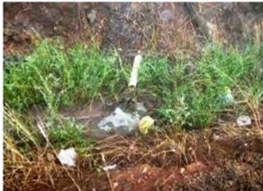
Fotografia 01: Cano de lançamento de efluentes
