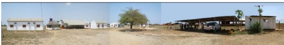
Figura 02: CTN – Foto panorâmica interna: situação anterior à intervenção (Setembro/2009)
