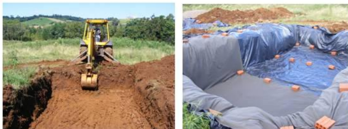
Figura 3 – Escavação em solo e impermeabilização dos FPM
