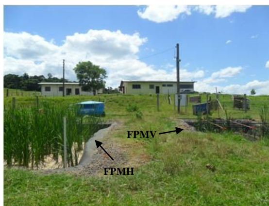
Figura 7 – Vista geral do sistema
